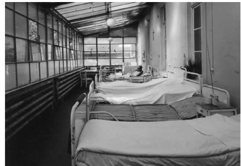
Abbildung 14: Krankensaal vor 1960 (Archiv des Universitäts-Bauamts)
