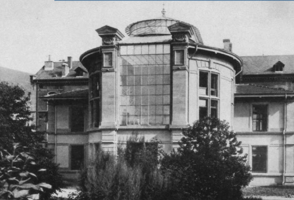
Abbildung 8: Hörsaal (ehemaliger chirurgischer Hörsaalbau (9))
